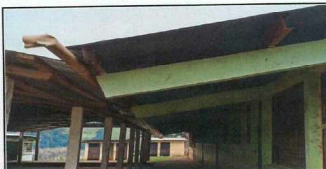
Foto 5: Se observa el deterioro de canales y bajadas de aguas pluviales de la estructura portante de tres aulas y dos bodegas
