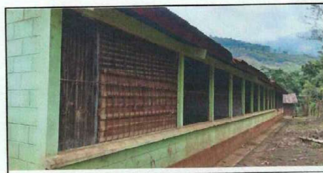
Foto 6: Se observar el deterioro de pintura interior y exterior de las estructura portante de tres aulas y dos bodegas.
